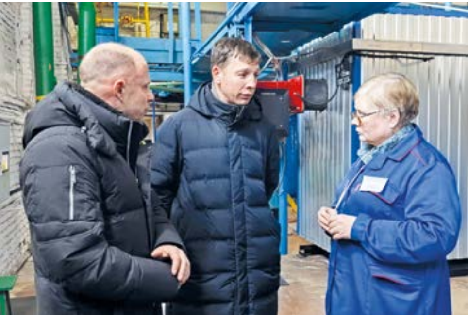
↑ Глава района Александр Налётов и глава Усадищенского поселения Андрей Сорокин в котельной, где сейчас также расположена система водоподготовки
